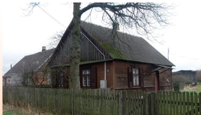
Dom drewniany z elementami snycerskimi w Męciszowie nr 40
