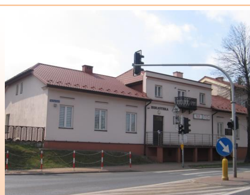
Budynek biblioteki w Zwoleniu
