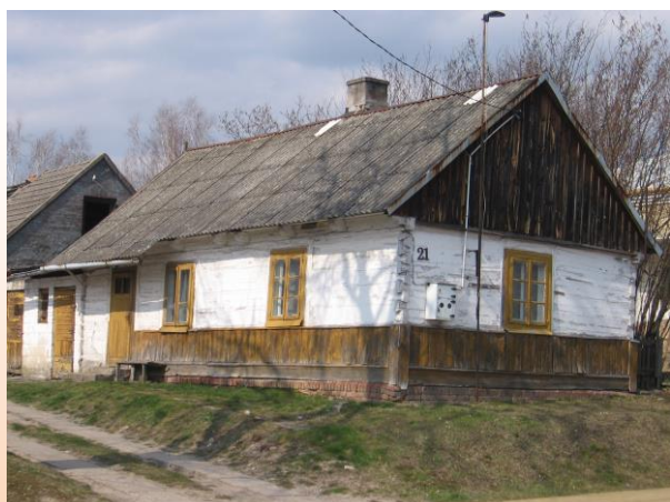
Dom drewniany z widoczną konstrukcją wieńcową przy ul. Słowackiego 21
