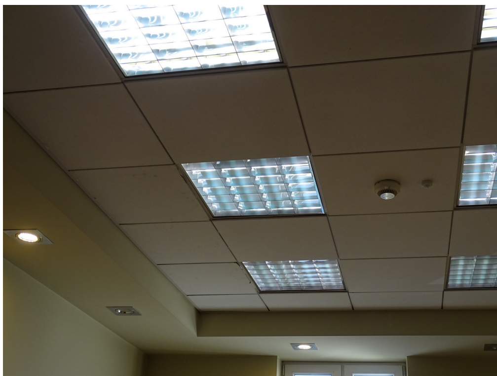
149 opraw 60 x 60 cm wpuszczanych w sufit modułowy
