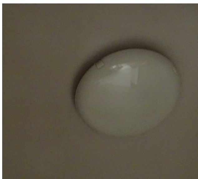
48 opraw typu plafon, zamontowanych natynkowo
